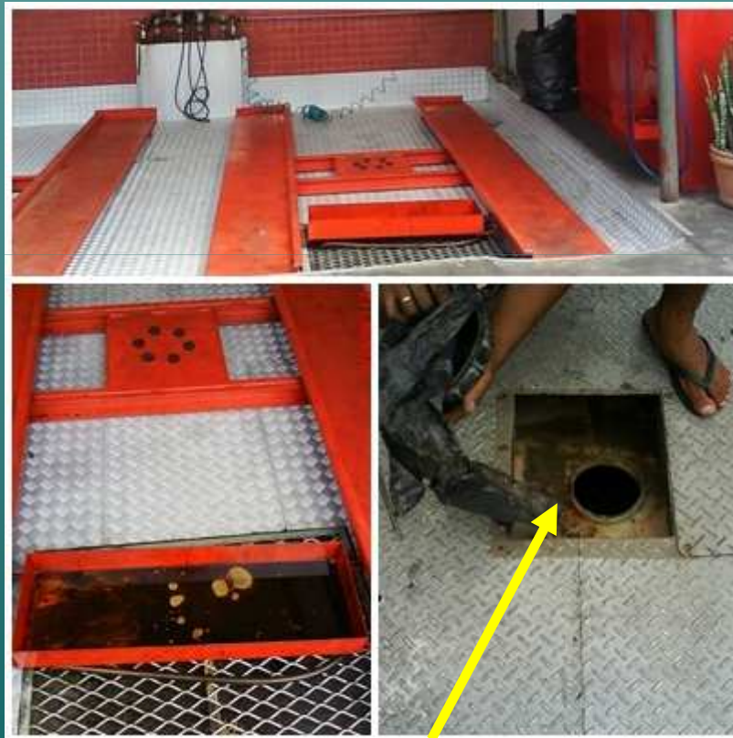
Instalação do reservatório de OLUC , no processo de retirada do óleo usado do Carter.
