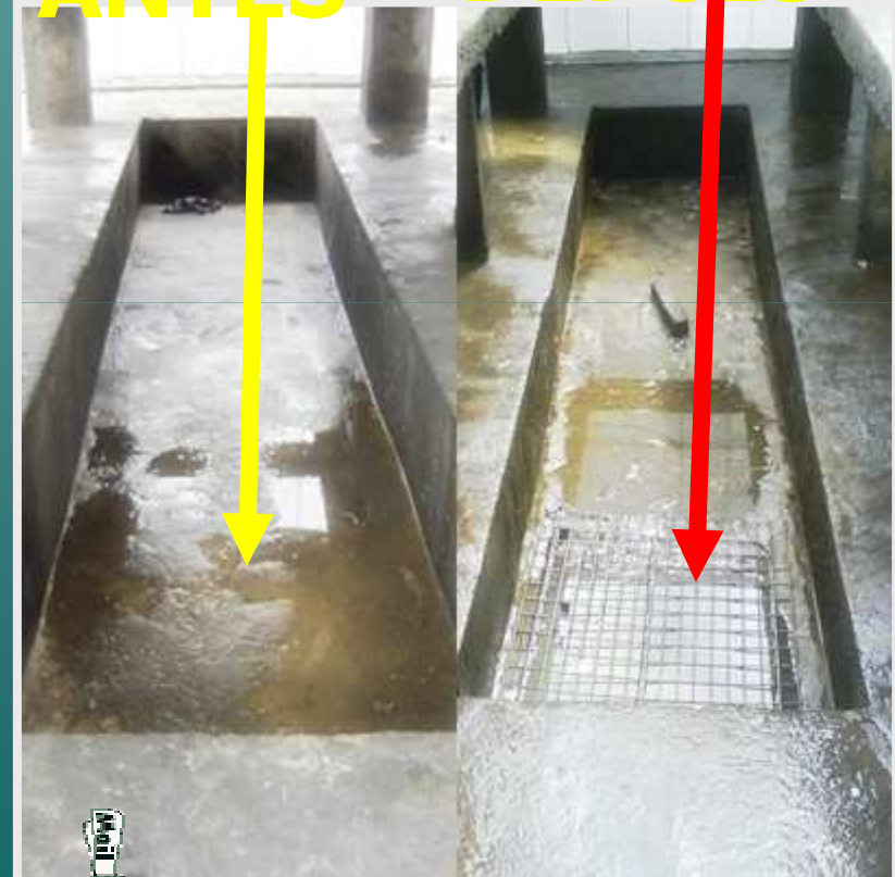
Instalação de caixa de areia na rampa de lavagem.
